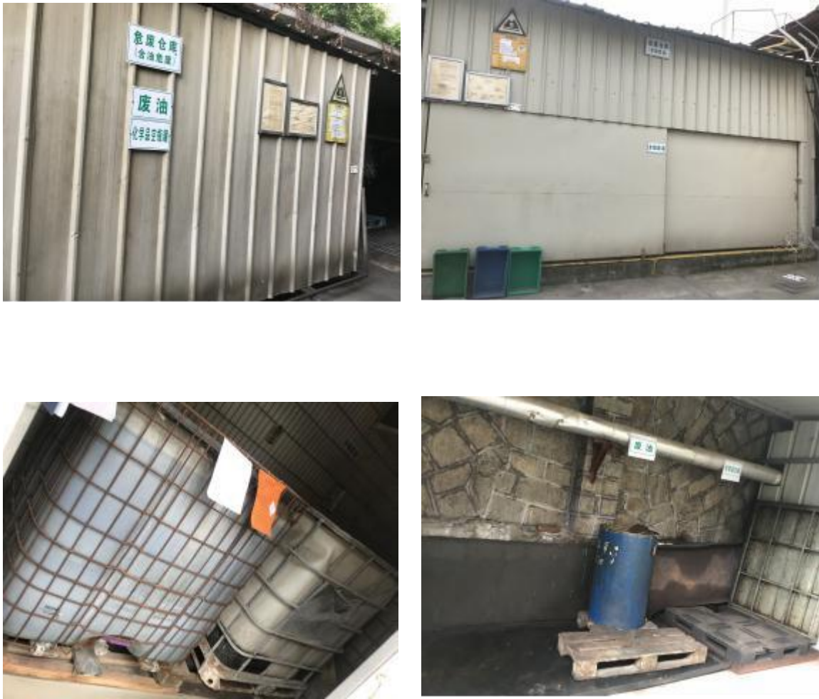
图10.1-11危险废物分类收集及暂存场所
