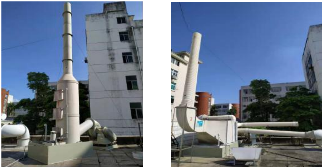
图3.4.6 酸雾废气处理设施图
